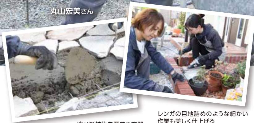
確かな技術を要する玄関アプローチの石貼り施工
